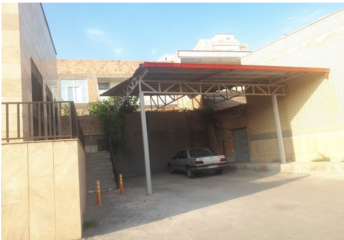
- نصب سایبان برای برج خنک کن
