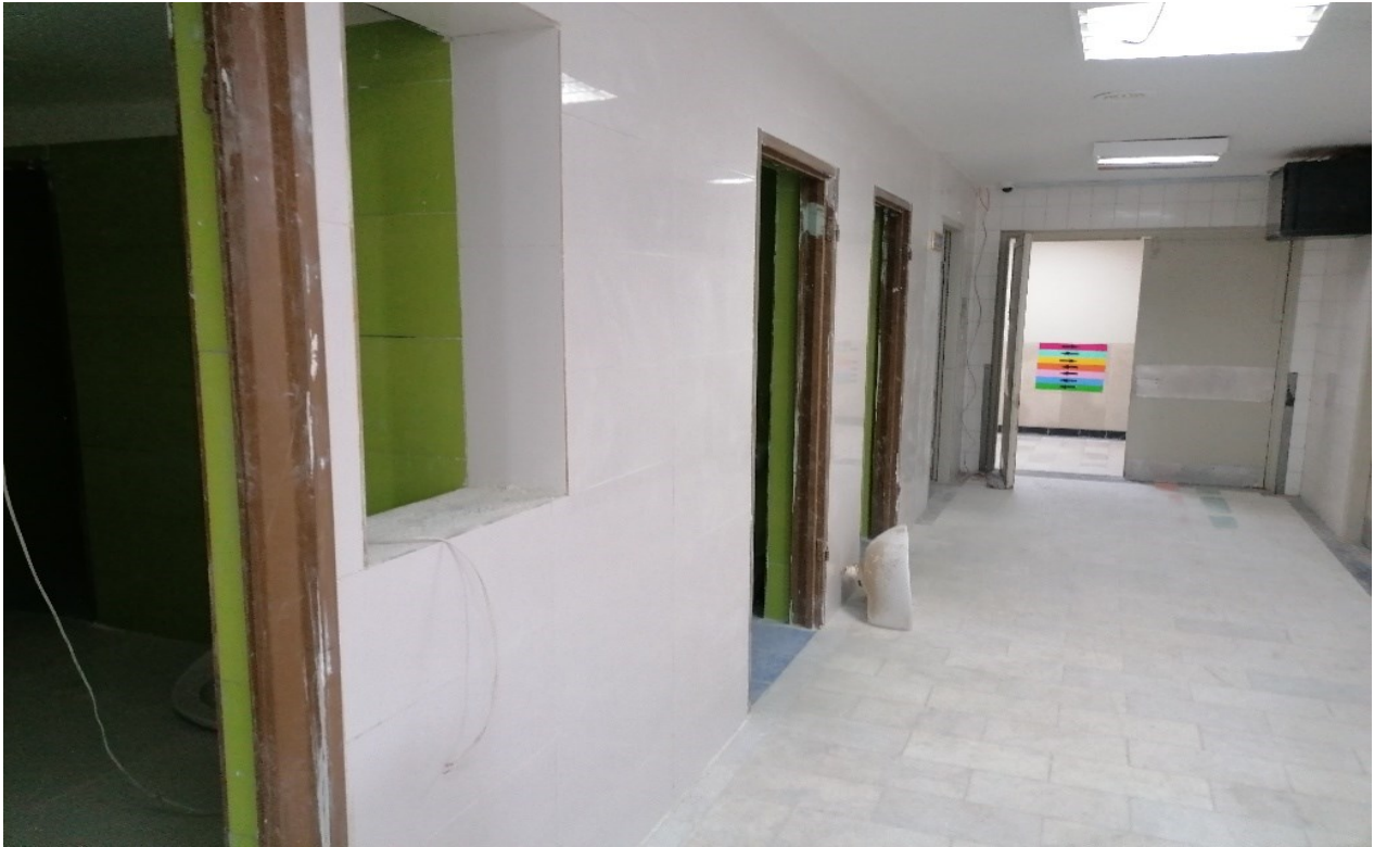
- ایجاد بخش ICU با تعداد ۱۲ تخت ( در حال اجرا ) به متراژ ۴۰۰ متر مربع
