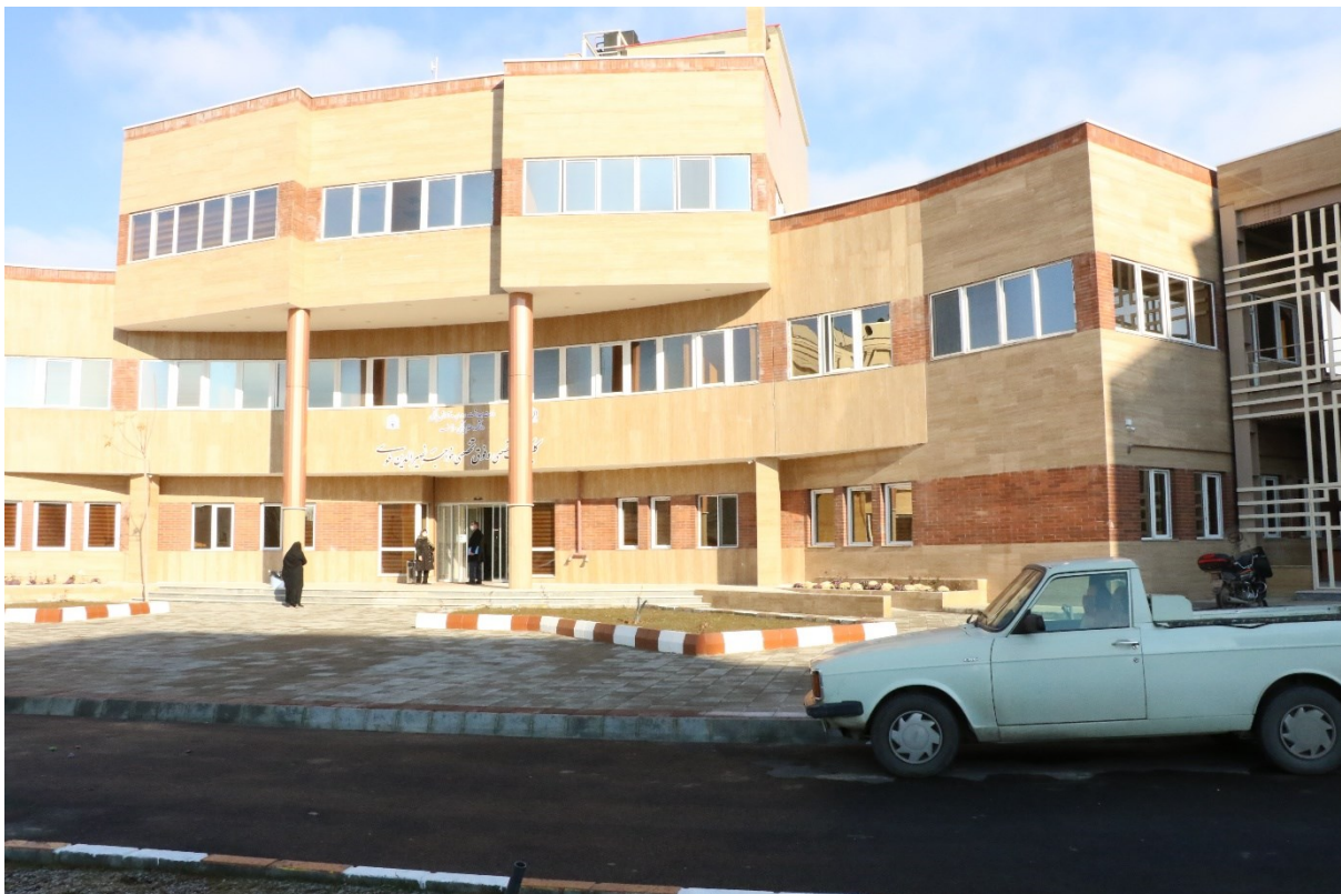
۶- احداث و تکمیل محوطه سازی ۱۱۵ بهرآباد به متراژ ۱۵۰ متر مربع
